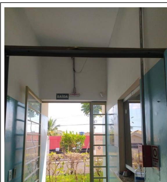
Luminária de emergência do tipo balizamento.
