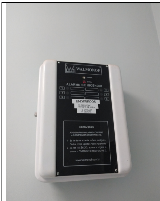
Central de alarme inoperante instalada no hall das salas técnicas.
