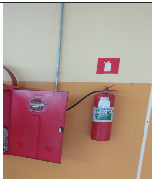
Extintor de Água Pressurizada existente na edificação.
