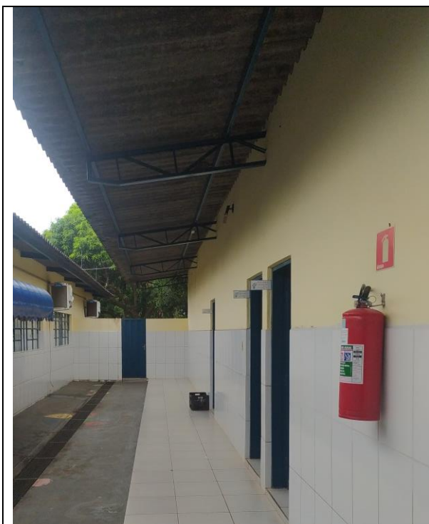
Extintor de Água Pressurizada existente na edificação.
