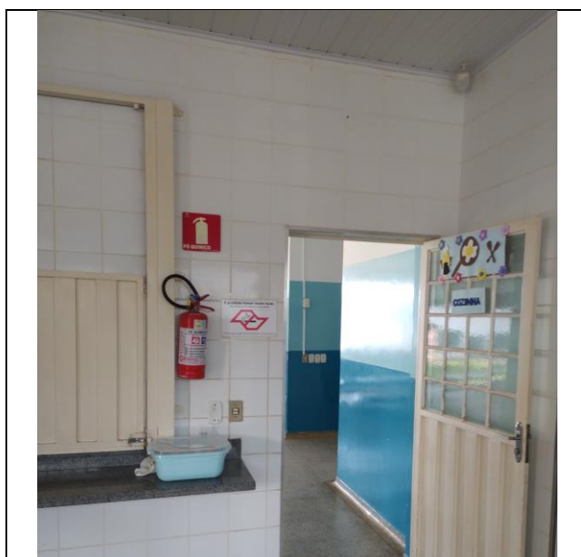
Extintor de pó químico seco existente na edificação.
