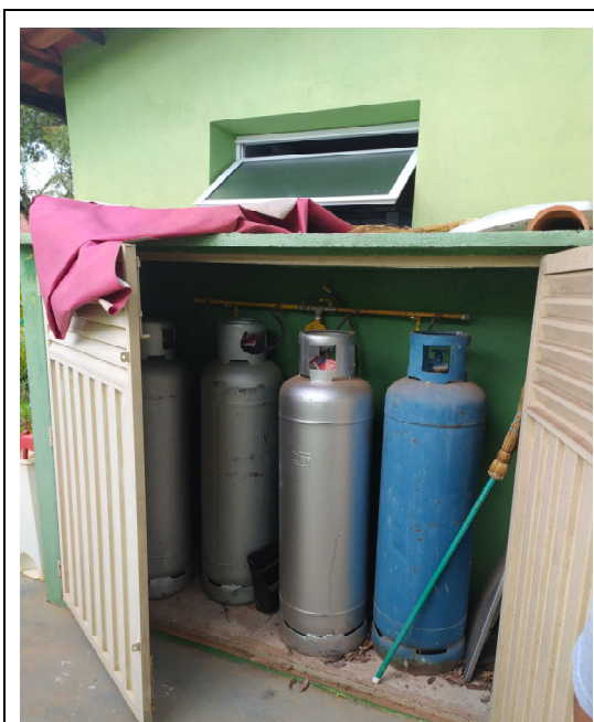
Vista da Central de GLP existente na Edificação.
