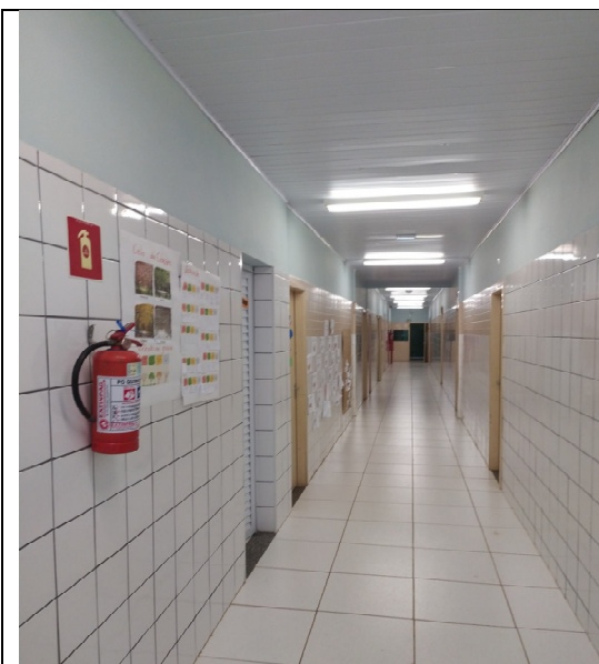
Extintor de Pó Químico Seco existente na edificação.
