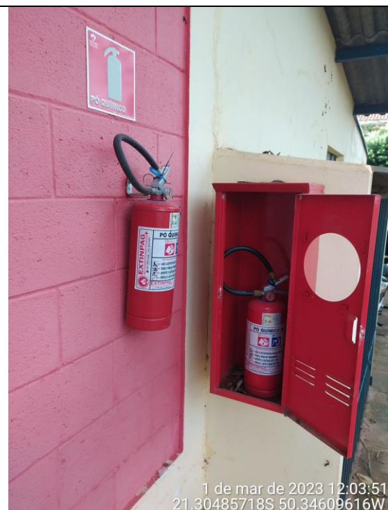
Extintores de Pó Químico Seco existentes na edificação.
