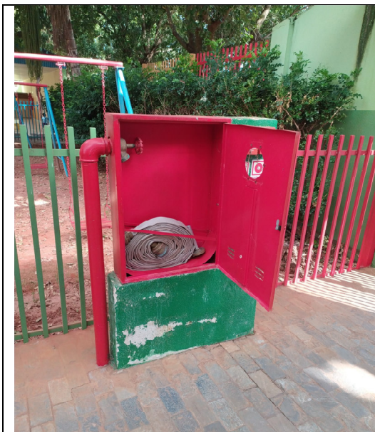
Abrigo do hidrante existente na edificação, sem esguicho regulável, chave storz e engate rápido; necessário substituição de mangueira.
