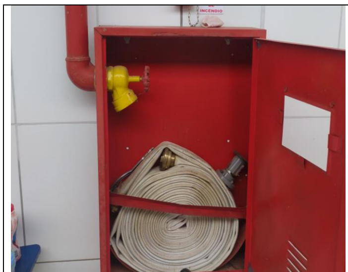
Vista de abrigo do hidrante existente na edificação
