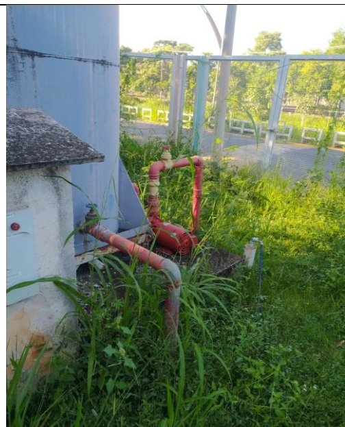
Tubulação de saída do reservatório que deverá ser pintada.
