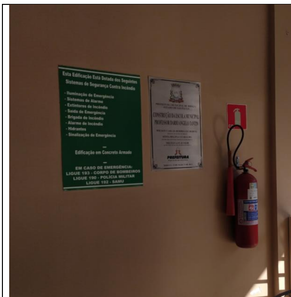
Sinalização de identificação dos equipamentos de incêndio presentes na edificação, e de extintor de incêndio.
