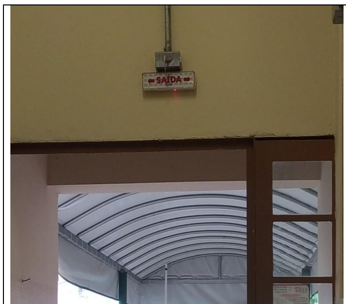
Luminária de emergência do tipo balizamento existente.
