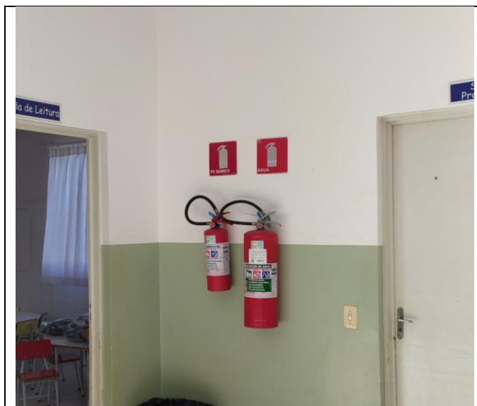
Par de extintores (Água Pressurizada e Pó Químico Seco) existente na edificação.
