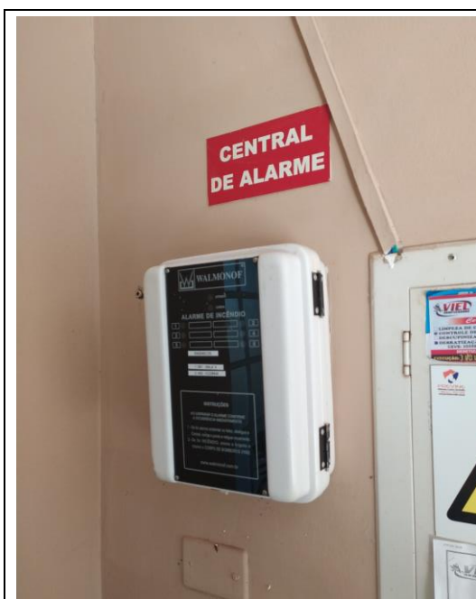
Central de alarme instalada na recepção.
