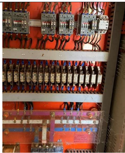
Barramentos de cobre
