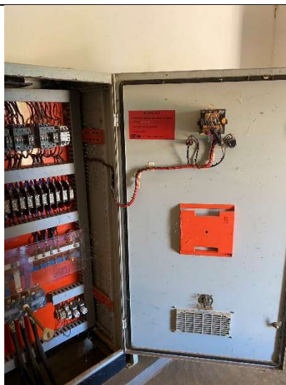
Falta de diagrama unifilar
