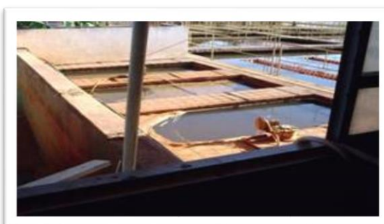
Figura 10 –Floculadores Antigos Atualmente Auxilia o Processo de Mistura
