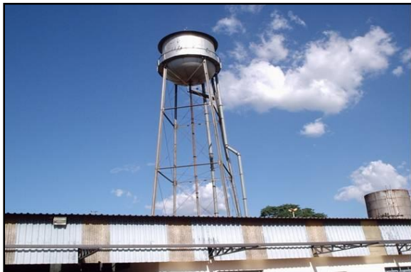
Figura 15– Reservatório Elevado em Estrutura Metálica - Anderson Clayton
