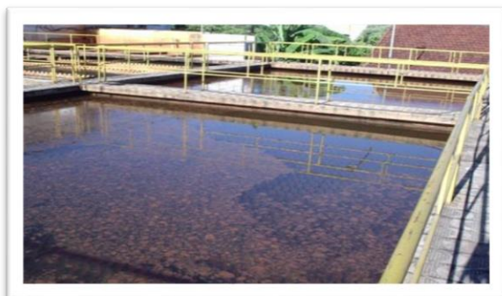
Figura 11 – Detalhe do Decantador com Flocos em Suspensão
