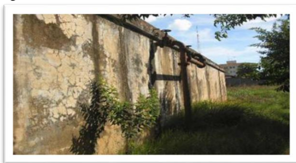
Figura 19 - Reservatório Isabel Marin – Detalhe com Trincas
