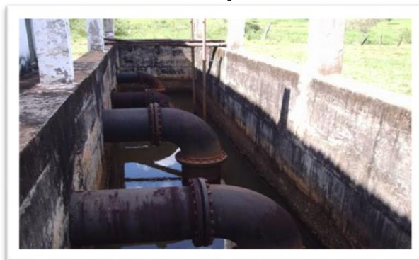
Figura 4 – Detalhe do Poço de Sucção e das Tubulações
