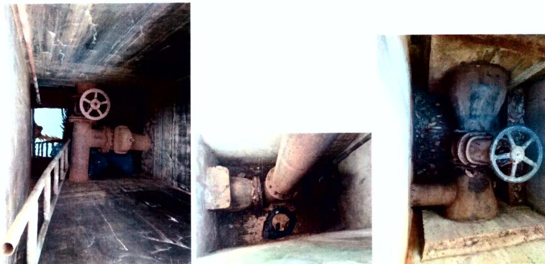
Interligações tubulares subterrâneas ligando os reservatórios entre si, permitem transferências de volumes reservados para transporte em regiões diferentes na rede. Tubos de aço 8", com revestimento externo betuminoso, subterrâneos em conexão a registros de gaveta 8" classe PN10, flangeados. Interligam os reservatórios de forma a conduzir volumes entre eles e também migrar volumes para direções diferentes na rede, de acordo com a necessidade do momento.
