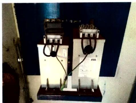
Disjuntor marca BEGHIM, série Soprarc tipo PL 15C no. 8811, tensão nominal 17,5 KV e corrente nominal 630 A, NBI 110 V, relê de abertura 220 volts 60Hz. Capacitor trifásico para correção de fator de potência da marca AABB tipo seco auto regenerativo, modelo CLMD53 Qn 30KvAr , capacitância 184 $\mu$ F.
