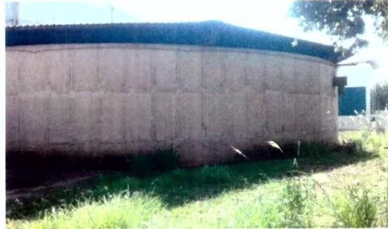
Reservatório semi-enterrado Matéria de capacidade de 1.300 m<sup>3</sup>, construído de concreto e armações estruturais na forma circular com altura do chão de 3,16 metros, e profundidade interna de 4,90 metros e diâmetro de 18 metros. Revestimento impermeabilizante interno Viaplus com reforço de poliéster. Cobertura de estrutura metálica com telhas de aço galvanizadas e borda oitavada. Ano de construção 2004 pela empresa Matéria Perfuração de Poços.
