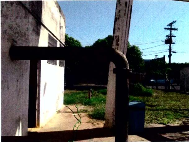
Casa de bombas Antiga, construção em alvenaria ao nível do chão, com uma base elevada de alvenaria, suporta dois conjuntos motobombas para bombear água do reservatório semi-enterrado retangular para o reservatório elevado e simultaneamente diretamente à rede.
