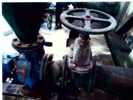
O cavalete, em cada saída das bombas, está instalado conexões, redução flangeada de 5" X 12", válvula de retenção tipo wafer 12" dupla portinhola e registro gaveta 12" classe PN10, de Fo.Fo, marca Barbará. Na sucção da bomba também a redução de aço flangeada de 6"X 8" e registro de gaveta 8" classe PN10 de Fo.Fo.
