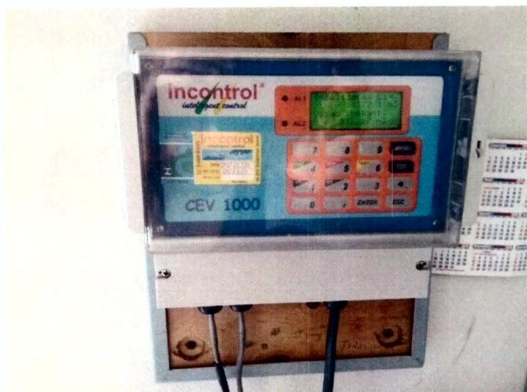
Conversor microprocessado CEV1000, transmite 4-20 mA e pulso, possui comunicação digital RS 485.. Indicação com seis dígitos na totalização e quatro na vazão instantânea. montagem painel IP-30.
