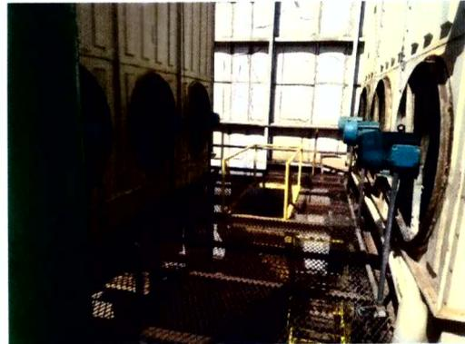
Escada para acesso ao pavimento superior. Piso de sustentação das Torres e para tráfego de pedestre, composto por cantoneiras e chapa expandida para a livre passagem do ar succionado pelos ventiladores.
