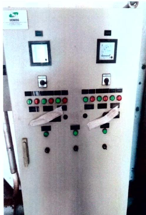
Quadros de comando de partidas das Torres de Resfriamento, quatro Torres em operação e duas Torres em standby. Comando de partidas dos motores dos ventiladores do tipo Partida Direta. Como cada Torre tem três ventiladores então, 18 motores a dar partida.
