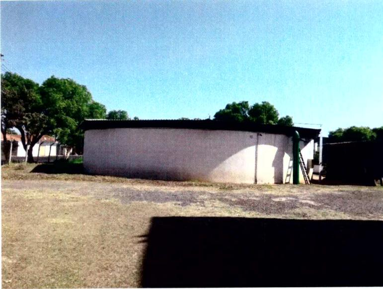
Reservatório Redondo antigo, capacidade de 1.000m<sup>3</sup>, semi-enterrado , construído de alvenaria e armações estruturais na forma circular com altura do chão de 3,10metros e profundidade interna de 4,10 metros e diâmetro de 18 metros. Revestimento impermeabilizante interno Viaplus com reforço de poliéster. Cobertura de estrutura metálica com telhas de aço galvanizadas e borda oitavada. Totalmente reformado em pela empresa Matéria Perfuração de Poços.
