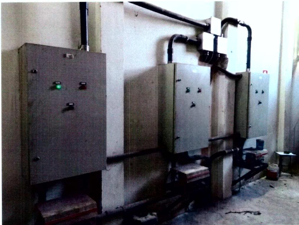
Três quadros elétricos de comando das três bombas, partida tipo compensadora, com autotrafo instalado logo abaixo dos quadros elétricos.
