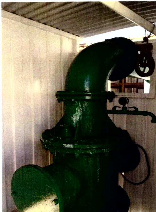
Cabeça do poço com cruzeta de aço e flange de ancoramento da coluna edutora, tomada de amostragem de água e manômetro instalado, acesso restrito ao tubinho de medição de nível estático e dinâmico do poço.
