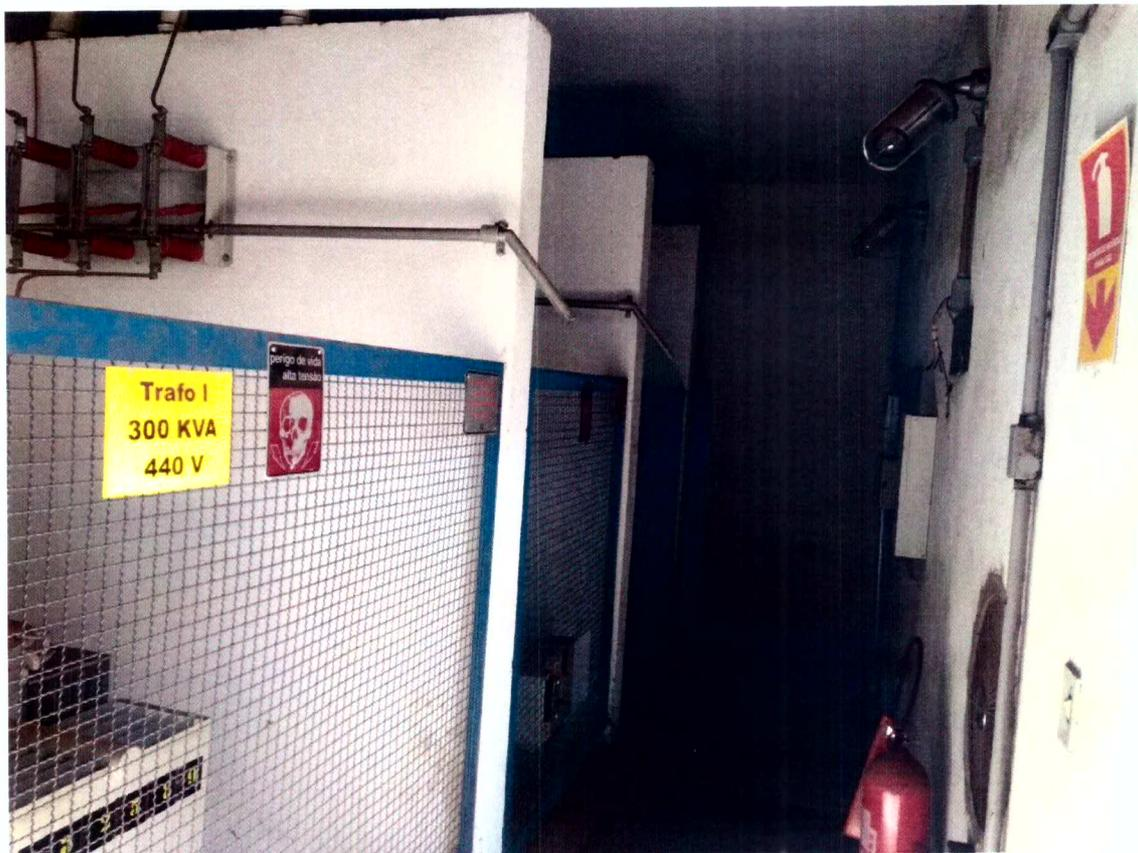
Cubículos de Trafos. e outros equipamentos elétricos de comando e proteção do sistema, como condutores nus, chaves facas, disjuntores e fusíveis protetores.
