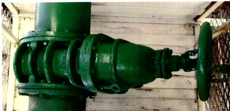
Válvula gaveta 12" em Fo.Fo. classe PN10, haste não ascendente em aço inox AISI 410, castelo aparafusado, vedação em bronze ASTM B-62, flangeado conforme ISO 2501, face com ressalto.
