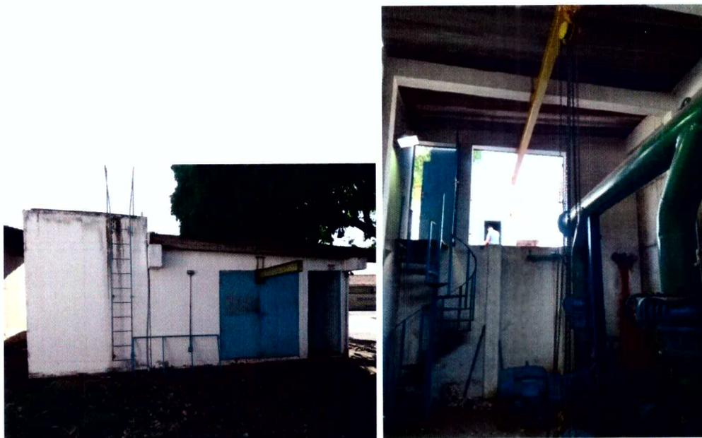
Casa de bombas Matéria, construída em 2.004, com nível rebaixado, possui uma escada tipo caracol para acesso ao nível rebaixado. Possui também uma monovia instalada uma talha de corrente manual, 2 tons, para içamento e locomoção de peças quando em manutenção.
