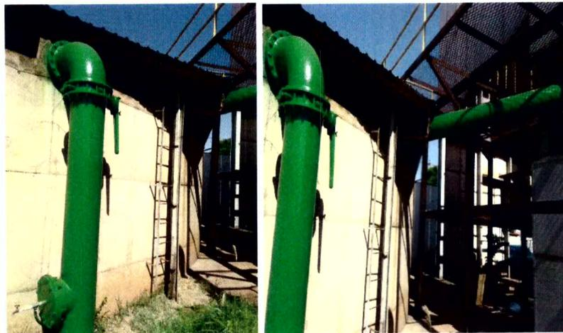
Tubos de 12" que ascendem do chão para encher os reservatórios com a água resfriada, possuem válvulas borboletas tipo wafer para o controle da distribuição.
