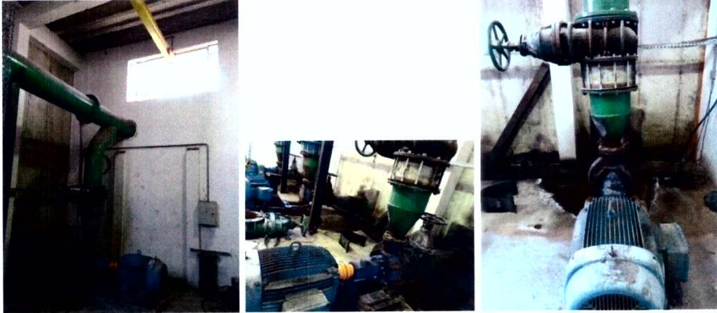
3 conjuntos de motobombas iguais que succionam a água do poço de sucção e bombeia para a adutora de 2.000 metros e 300mm diâmetro.
