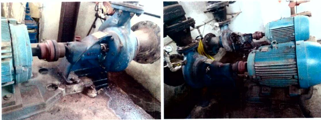
Dois conjuntos motobombas de um estágio, sucção simples com válvula de Pé e sistema de escorva, da marca IMBIL, modelo tipo ETA – 100/200 de Ferro Fundido, vazão 150 m<sup>3</sup>/h, acoplamento elástico, Motor Elétrico marca WEG, 30 CV / 4 polos (1.750rpm) 2 tensões (220/380)
