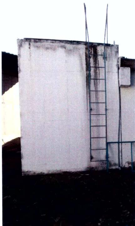
Poço de sucção incorporado a casa de bombas, uma intermediação da passagem da água do reservatório Matéria para a sucção das bombas de recalque para a rede.
