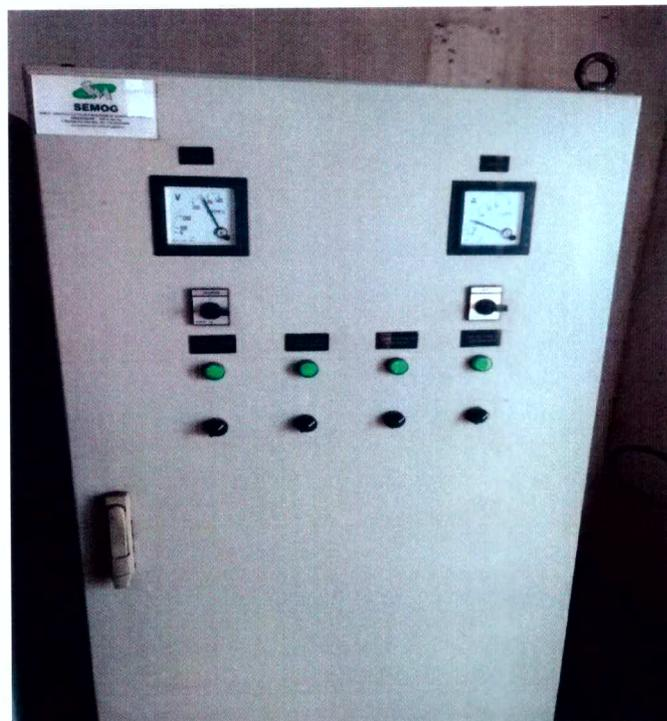
Quadro comando de inserção dos capacitores para correção do fator de potência da instalação.
