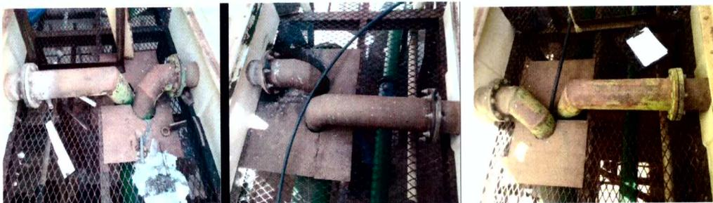
A água fria é coletada por tubos 8" diretamente das bacias das torres que por gravidade são conduzidas para o tubo de 12" coletor de água fria que encaminha aéreo diretamente para o maior reservatório de 1.300 metros cúbicos e também encaminha em tubo 12" vertical descendente para distribuição aos outros reservatórios.
