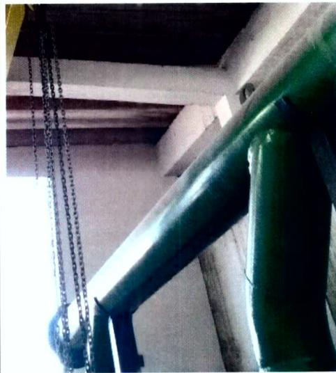
Cavalete de tubos de aço 12" de uniões em solda e flanges de aço carbono furação padrão ANSI. Composto por três derivações advindos das três bombas, que bombeiam, ao nível do piso externo, para a adutora já mencionada.
