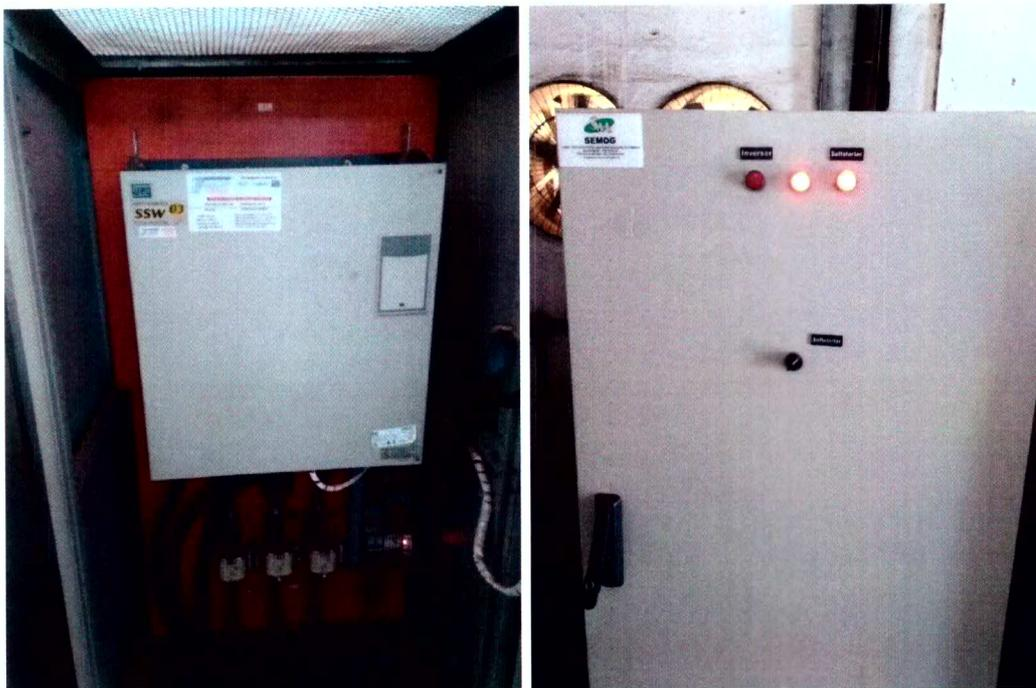
Painel de comando e partida do tipo SOFT STARTER aplicado na bomba submersa instalado no poço profundo. Marca WEG Full Digital PLUS SSW03, 410A / 440 Volts.
