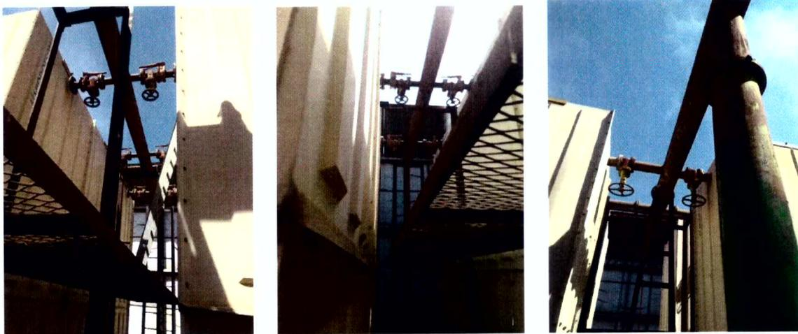
Tubo vertical de 12" eleva água quente e distribui para as 6 torres de resfriamento em derivações de tubos, conexões e registros de 8". As duas torres standby tem a sua distribuição em entradas individualizadas por cada célula, através de derivações de tubos, conexões e registros 4".
