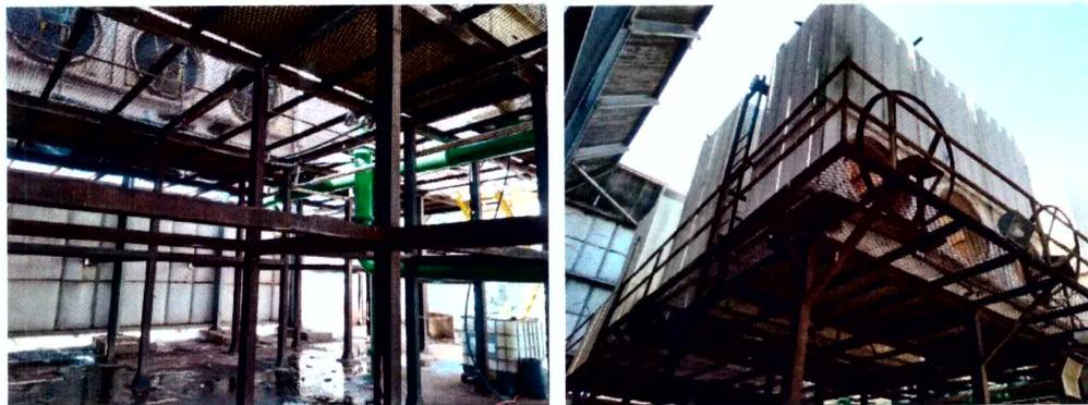
Estrutura de elevação das Torres de Refrigeração, construída com perfis "I" de aço de 8" e uniões por soldagem, de altura 4,20 metros, em colunas e vigamentos contraventados e travados. Com passarelas laterais dotadas de guarda-corpo.
