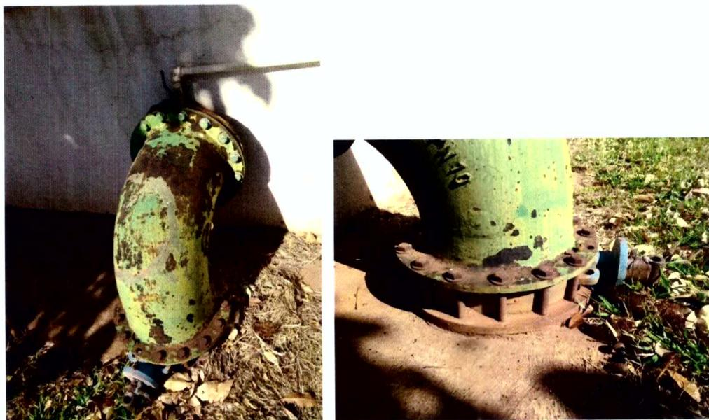
Curva de Ferro Fundido flangeada de 12", classe PN10, marca Barbará e válvula Borboleta tipo wafer de 12", classe PN10. Como terminal do cavalete das três bombas e iniciação da adutora 300mm, subterrânea, em tubos de PVC DEFOFO. 12" conexão tipo ponta e bolsa com anéis vedadores de borracha.
