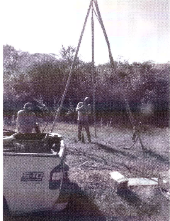
FOTO 2 - EXECUÇÃO DA SONDAGEM
