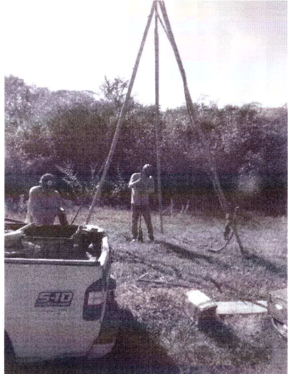
FOTO 2 - EXECUÇÃO DA SONDAGEM
